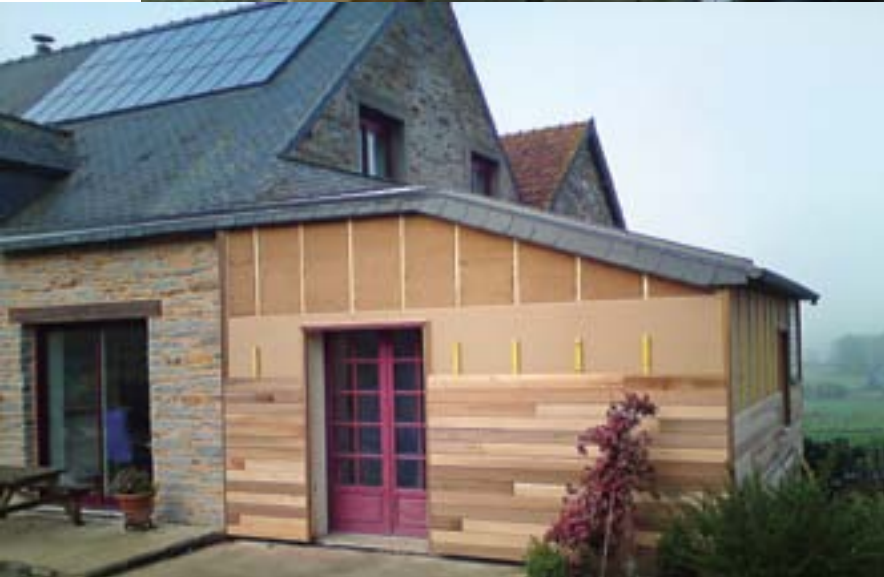
Der Anbau des alten bretonischen Steinhauses wurde mit PAVATEX gedämmt. Frühere Wärmebrücken wurden eliminiert, gleichzeitig stieg die Energieeffizienz.
