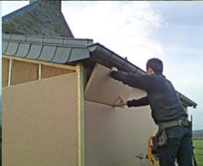
Der Anbau des alten bretonischen Steinhauses wurde mit PAVATEX gedämmt. Frühere Wärmebrücken wurden eliminiert, gleichzeitig stieg die Energieeffizienz.
