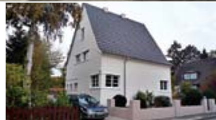
Sanierung Wohnhaus (D): Dach- und Fassadeninnendämmung
